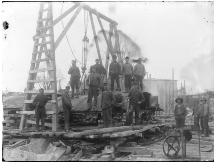
Arbetare vid kraftverksbygget i Gullspång, fotograf Axel Lundbäck.
